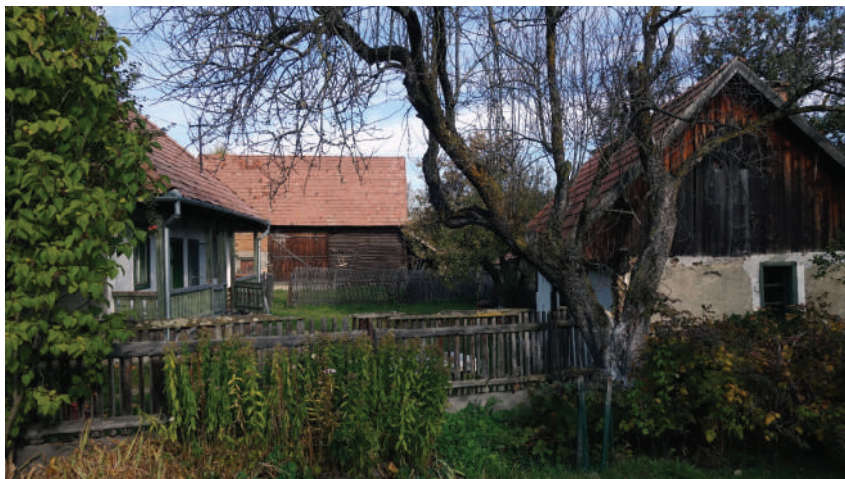
1. kép. A telek ( besső ) és épületei Forrás: a szerző felvétele
