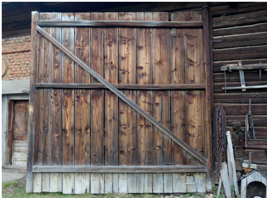
4. kép. A csűrkapu. A kapu hevedérei kívül vannak, hogy a csűrben bent cséphadaróval végzett kézi csépléskor a gabonamagvak a kapu belső sima felületéről a csűr közire pattanjanak vissza.
