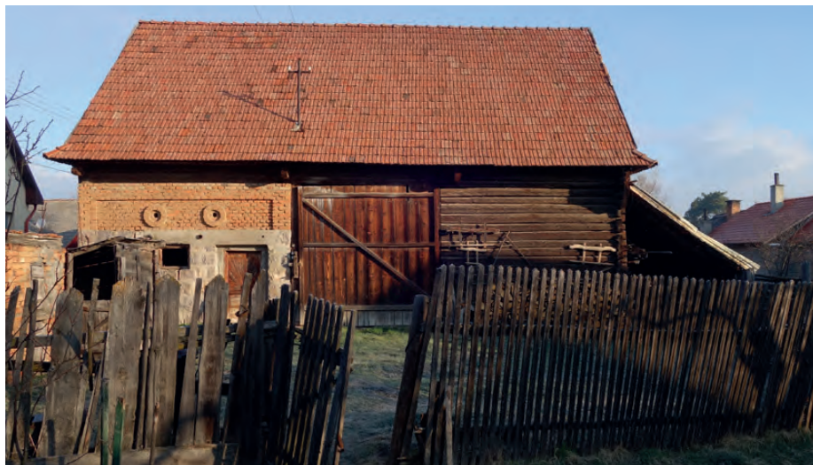
2. kép. A csűr és az istálló, a hátussó udvar . Az 1895-ben teljesen fából készült csűrt 1964-ben átépítették, és a telek irányába fordították, de eredeti formáját és méreteit megtartották. Az épület részét képező istálló kőből és téglából készült el, a régi zsëndely helyett az új épületet cseréppel fedték be.
