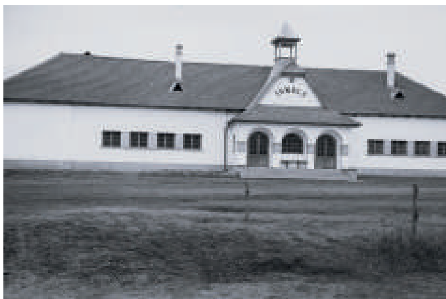
5. kép: Az 1948-ban felépített új iskola
