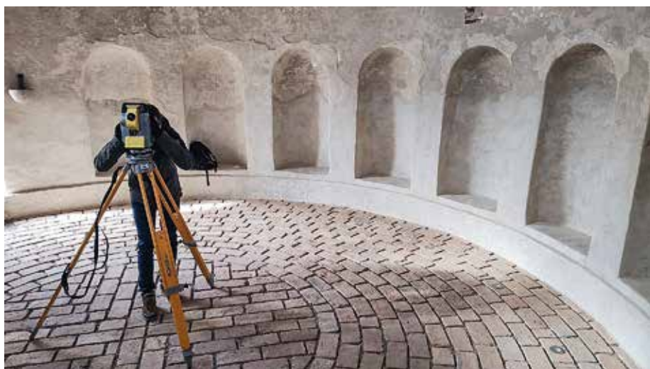
68. kép. Mérés a bényi belső (1-es számú) alapponton
