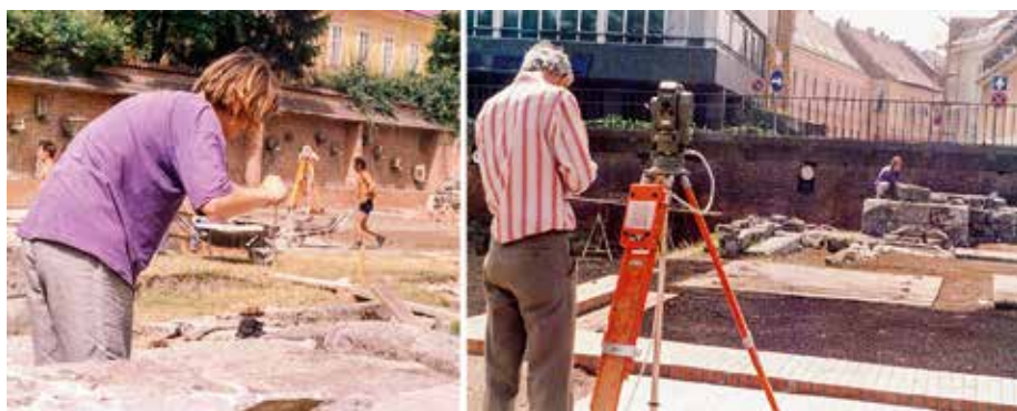
38. kép. A pillér-pontok előmetszése 1988 júliusában
