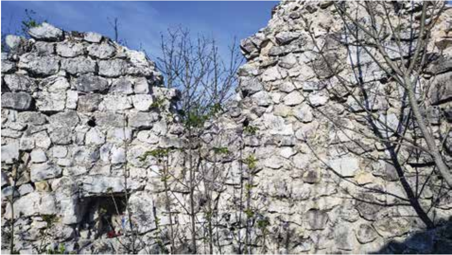
85. kép. A zámolyi rotunda észak-keleti belső fala, a négyszögletes, 46 cm mély, vélhetően szentségtartónak használt fülkével és az azonos szinten látható, kör alakú 3 lyukkal
