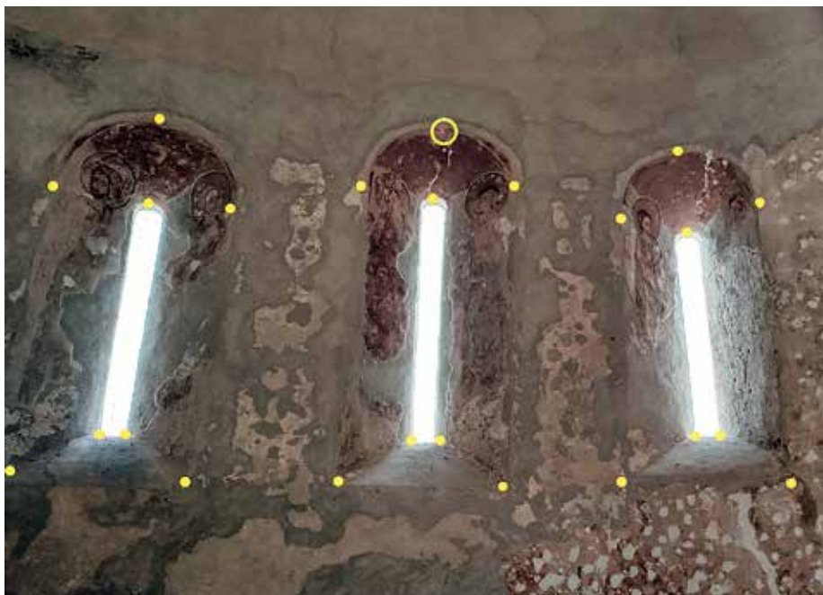
72. kép. A három keleti résablak a mért pontokkal. A középső ablak tetején a prizma nélküli távmérés lézerefénye is látható
