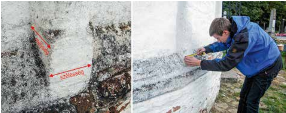
55. kép. Lizéna méretei és szélességének szalagos mérése
