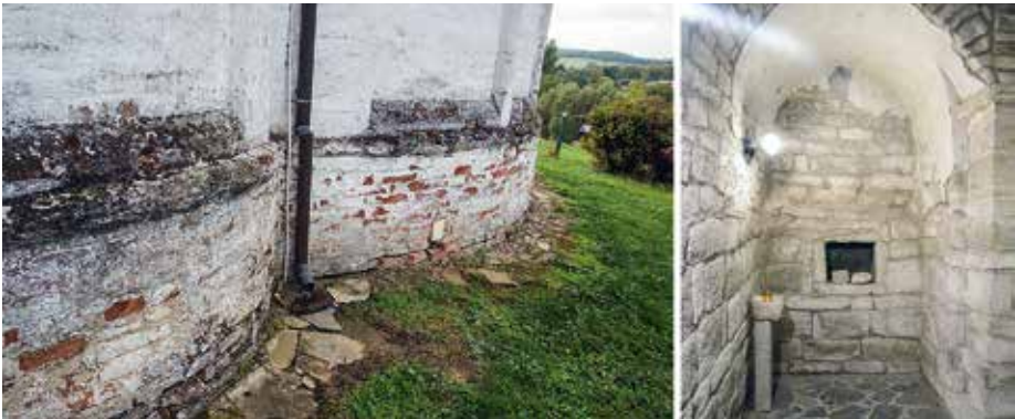
49. kép. Témánk szempontjából vizsgálatra ideális építmények: a kallódsdi templom vakolatlan téglalábazata (balra) és a tarnaszentmáriai altemplom kváderkő-fala (jobbra)
